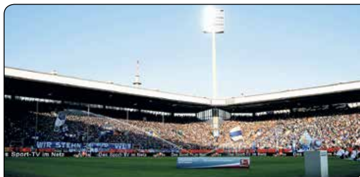
Ein tolles Fußballstadion: Das Bochumer rewirpowerSTADION.
