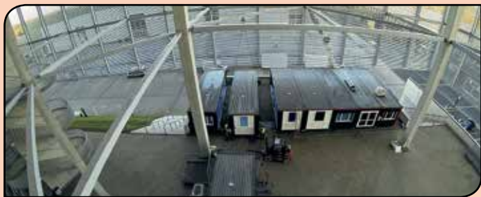
So sah es noch vor wenigen Tagen hinter Block 33 der Arena aus: Acht Container-Module bilden nun den neuen Fanshop.
